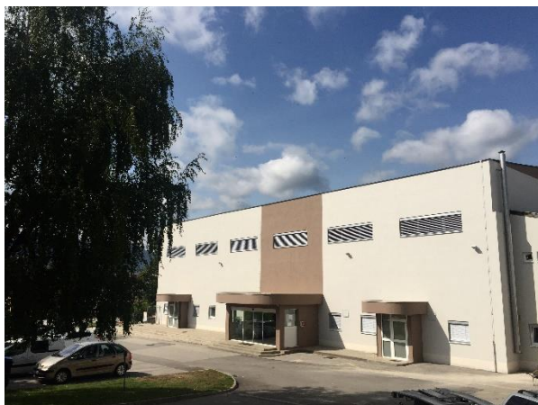
Fotografija št. 1: Parkirišče pred šolo
